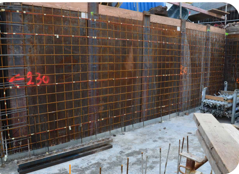
Voor de monitoring werden op verschillende hoogtes op de wapening van het kernbeton optische vezel rek- en temperatuurkabels bevestigd.
